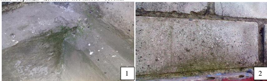
Рис. 1. Биоповреждение водорослями
